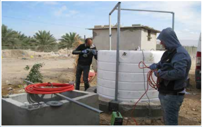
اكمال بناء جسم الهاضم تحت مستوى سطح الارض
