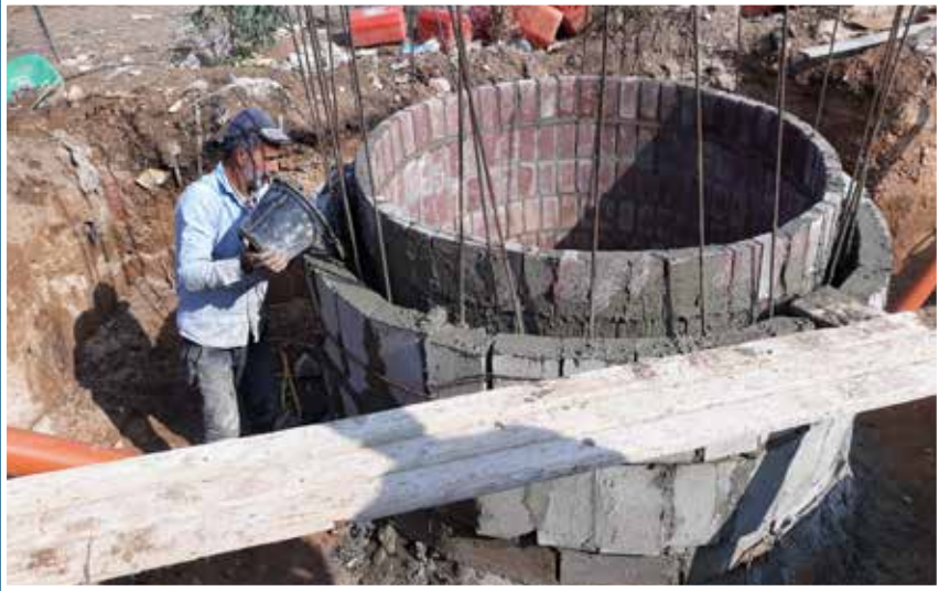
بناء رقبة الهاضم
