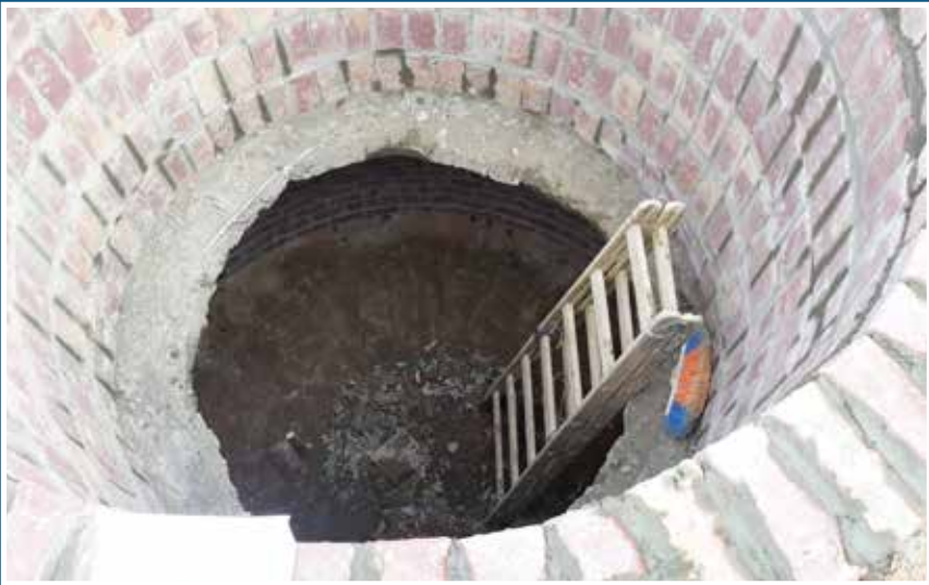
بناء رقبة الهاضم
