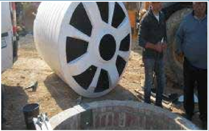
تجهيز قبة تجميع الغاز الحيوي وتركيبها في مكانها
